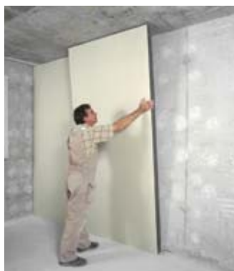
Pose d'un doublage isolant.
