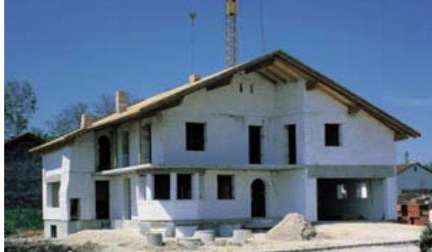
Construction en béton cellulaire
