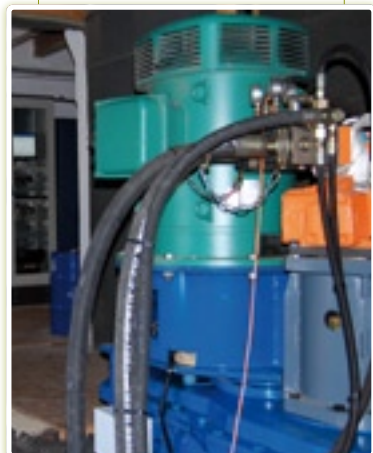
Multiplificateur (en bleu) et génératrice
