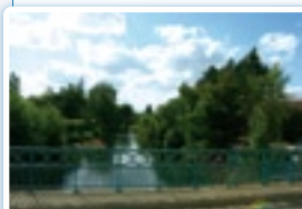
La Bèze à l'entrée de la centrale
