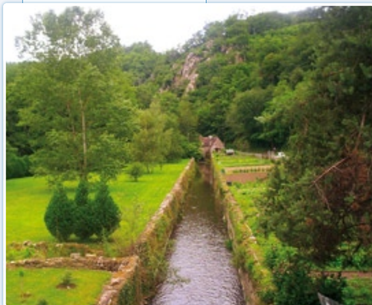
Avallon (89) / Canal de fuite
