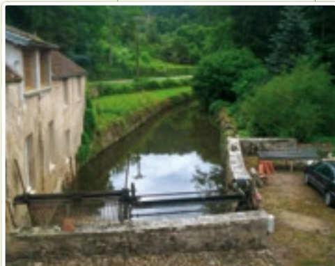
Canal d'aménée et dégrilleur
